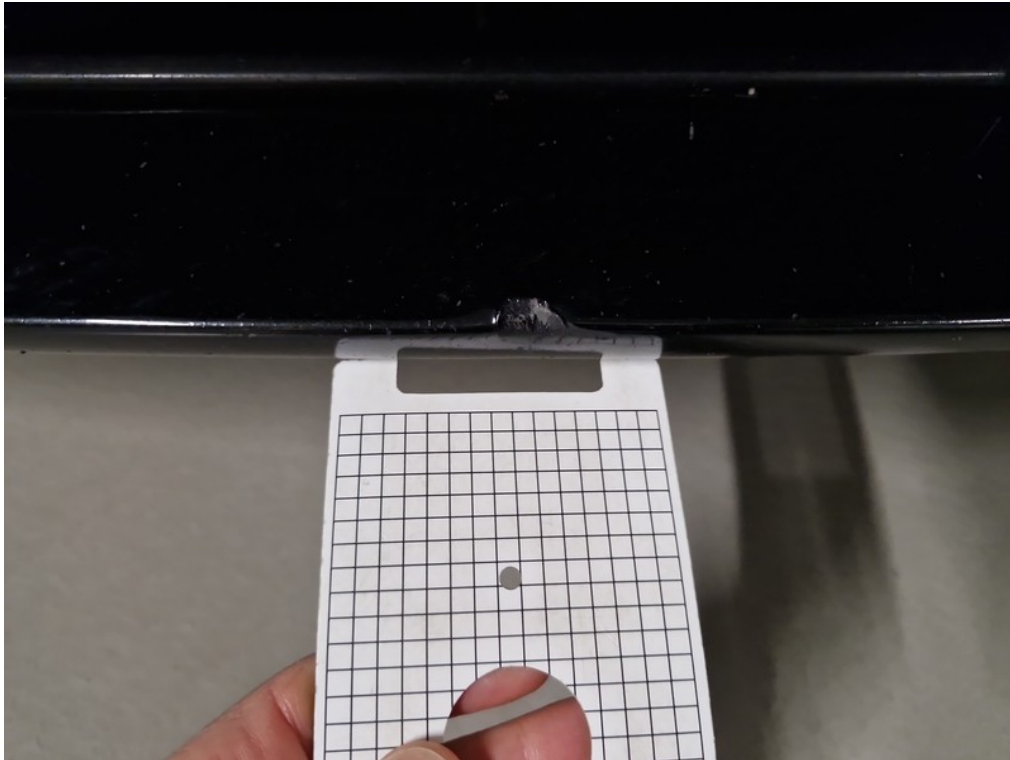
Viz popis k poškození č. 2
