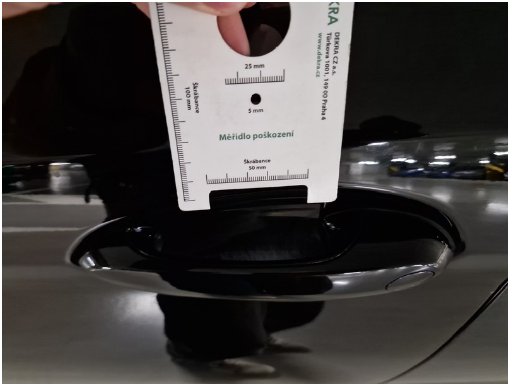
Viz popis k poškození č. 28
